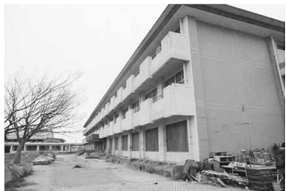
図3 震災後の湊第二小学校 (2階付近まで浸水)
