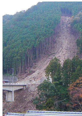
平成16年台風21号による 宮川村での斜面崩壊
