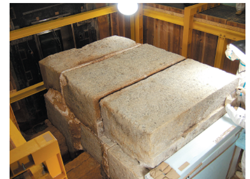
発掘された高松塚古墳石室と、地盤遺跡構造物の調査・保全技術と保存に関する研究の一環として実施した、石室解体時の墳丘地山安定支保工
