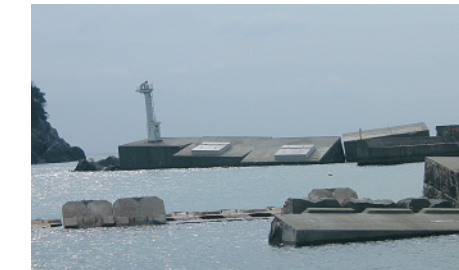
高波による防波堤の滑動被災
