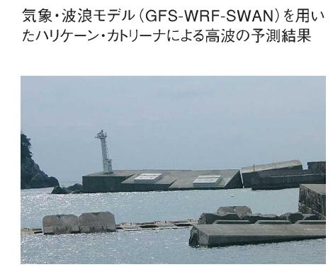
高波による防波堤の滑動被災
